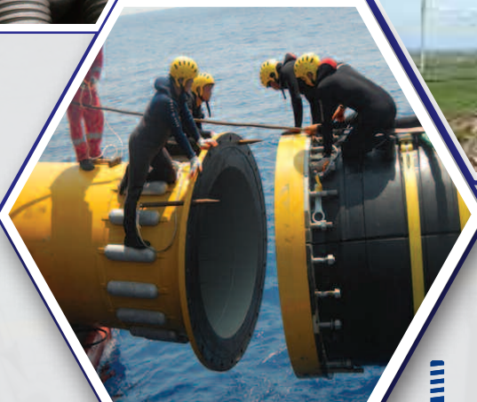
80 Kilometrelik Su Hattı Anamur - Kıbrıs Su Hattı Denizin 250 metre altında korozyona 100 yıl dayanımlı
